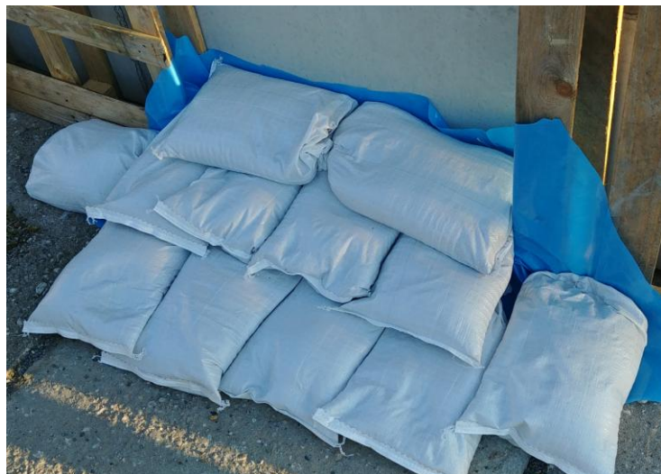
prinzipielle Verlegung - Türrahmen mit Paletten angedeutet
