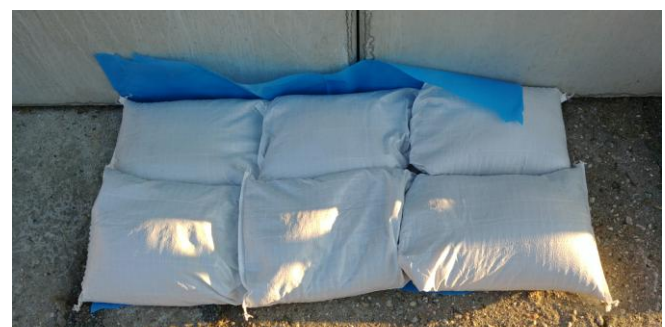
prinzipielle Verlegung – Kellerschacht angedeutet
